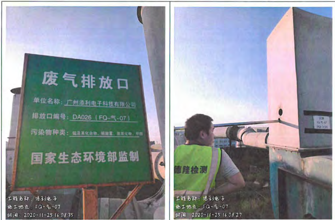
废气排放口 DA026 (FQ-气-07) 标志牌
