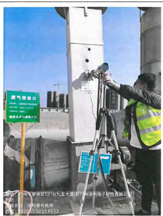
废气排放口 DA013 (FQ-气-03)
