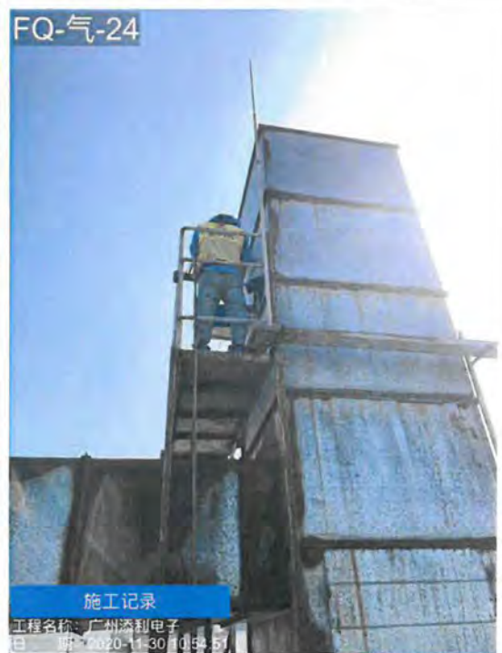
废气排放口 DA051 (FQ-气-24)
