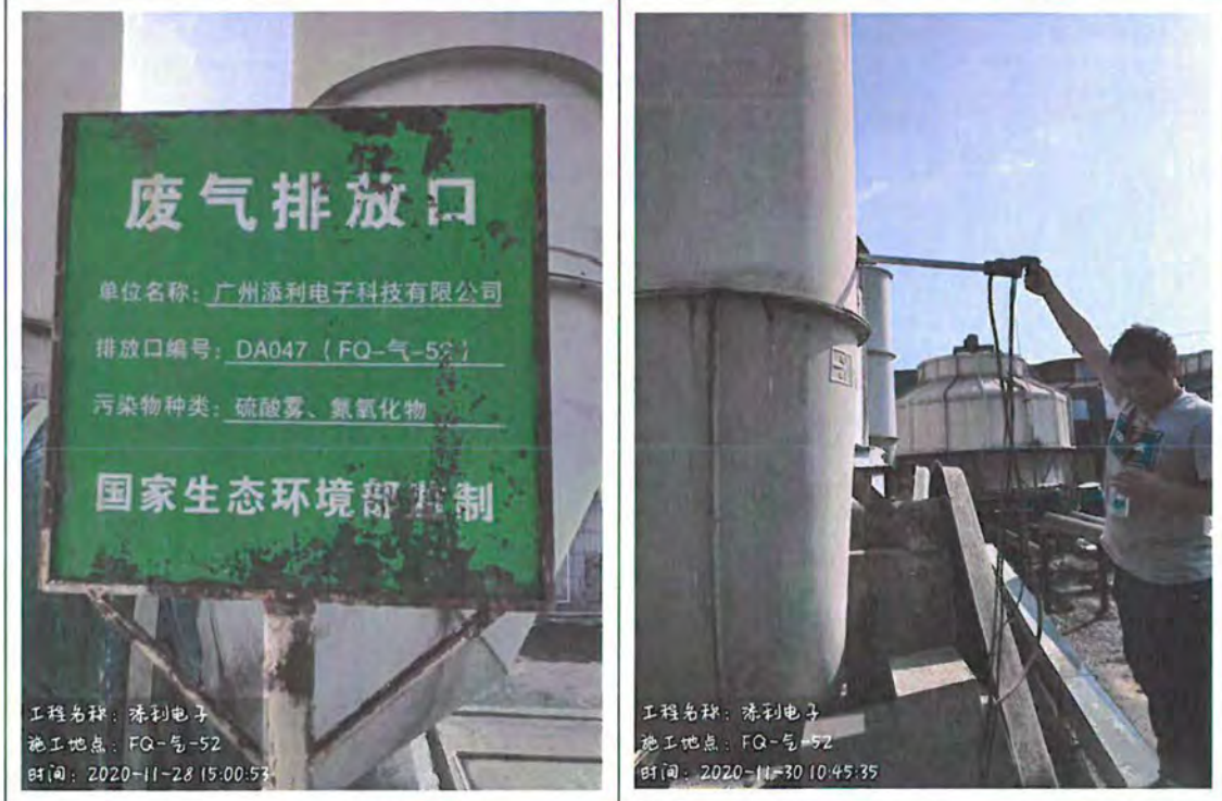
废气排放口 (FQ-气-52) 标志牌
