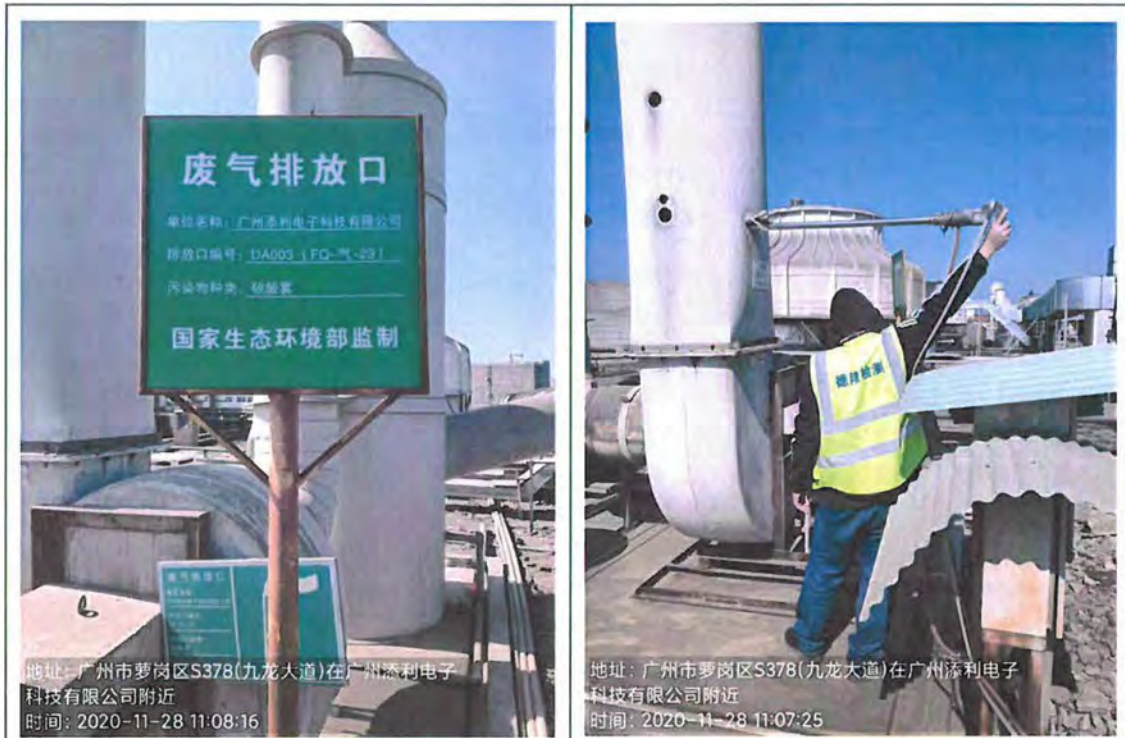
废气排放口 DA003 (FQ-气-23) 标志牌
