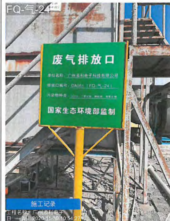
废气排放口 DA051 (FQ-气-24) 标志牌
