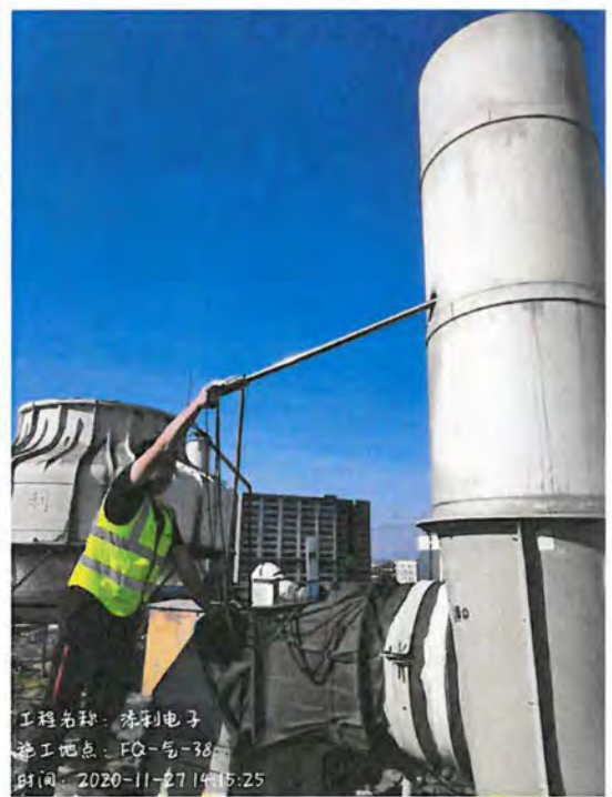
废气排放口 DA015 (FQ-气-38)
