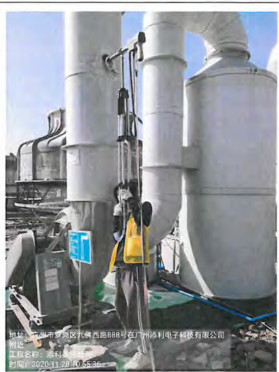
废气排放口 DA039 (FQ-气-20)
