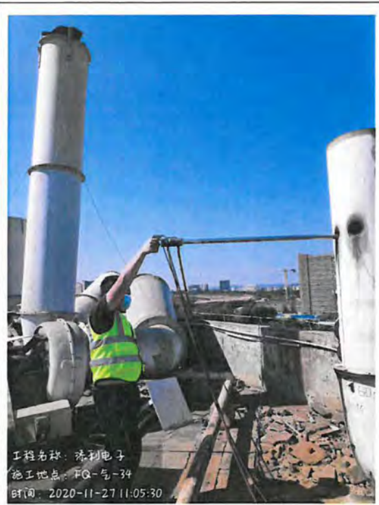
废气排放口 DA020 (FQ-气-34)
