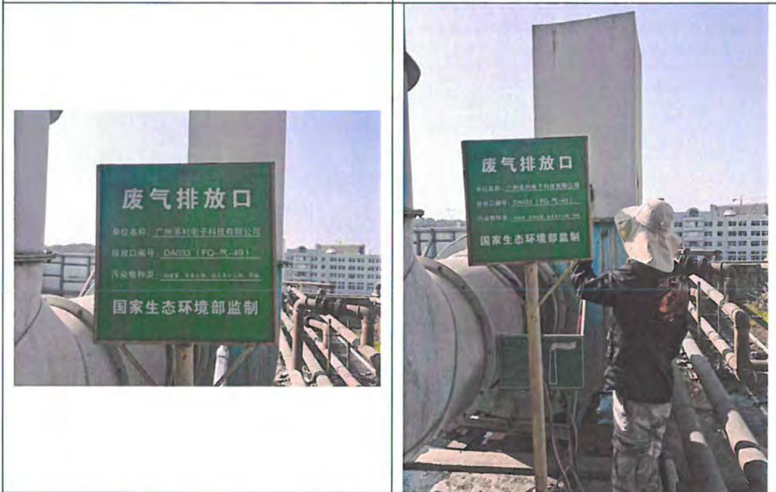
废气排放口 DA033 (FQ-气-49) 标志牌
