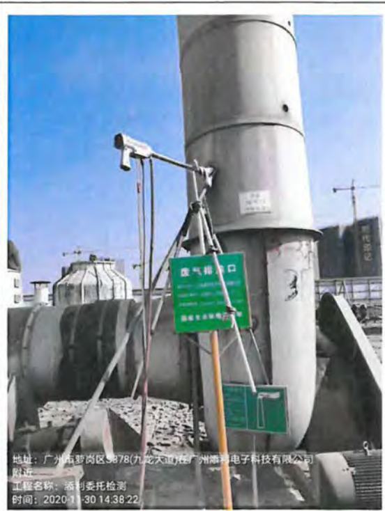
废气排放口 DA004 (FQ-气-13)
