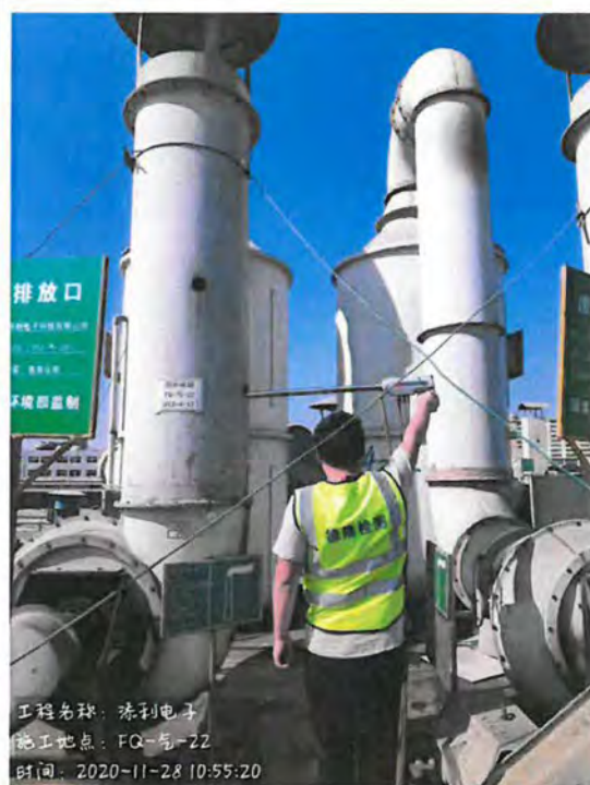
废气排放口 DA053 (FQ-气-22)
