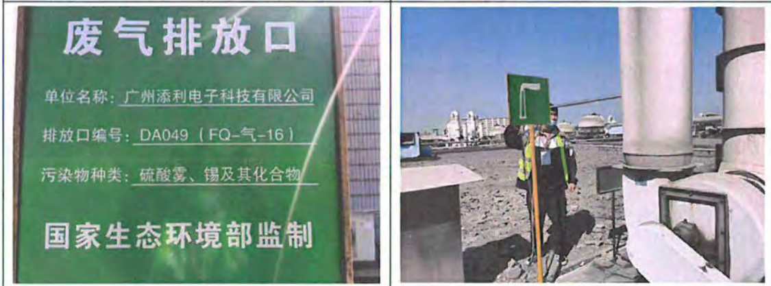
废气排放口 DA049 (FQ-气-16) 标志牌
