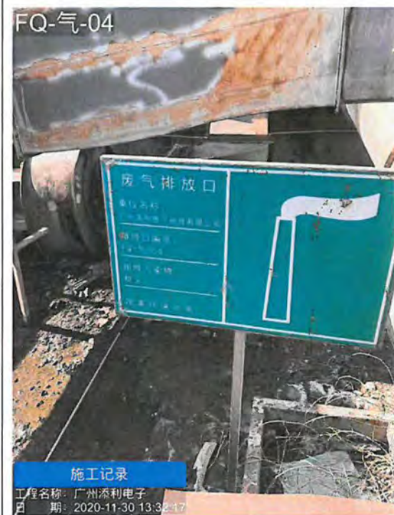
废气排放口 (FQ-气-04) 标志牌
