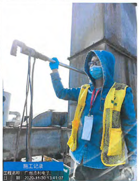
废气排放口 (FQ-气-04)
