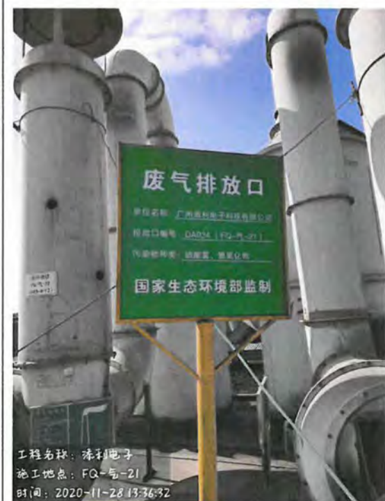
废气排放口 DA034 (FQ-气-21) 标志牌
