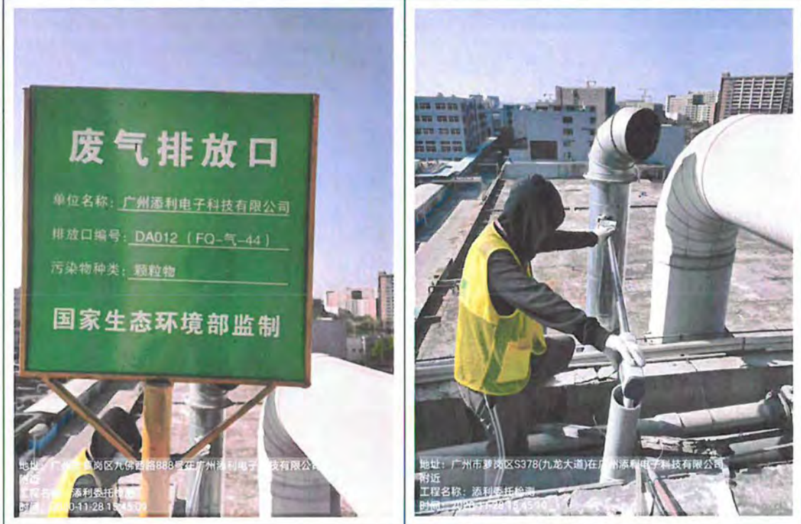
废气排放口 DA012 (FQ-气-44) 标志牌
