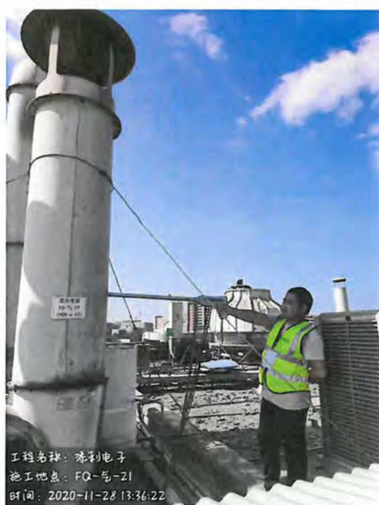
废气排放口 DA034 (FQ-气-21)
